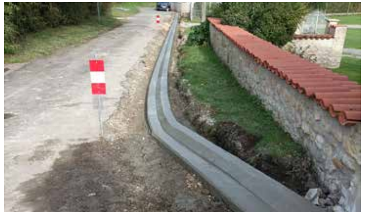
Réfection des bordures et de la chaussée en légende
