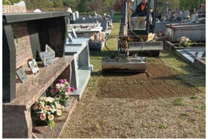
Réglage des allées du cimetière avant engazonnement
