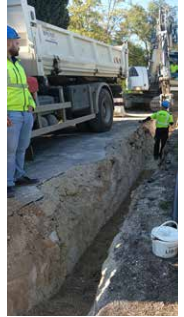
Renouvellement du réseau d'eau potable à Cornet.
