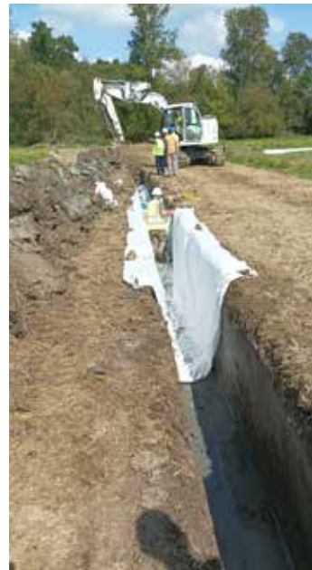
Pose du nouveau réseau d'eau potable dans la prairie de Cornet.
